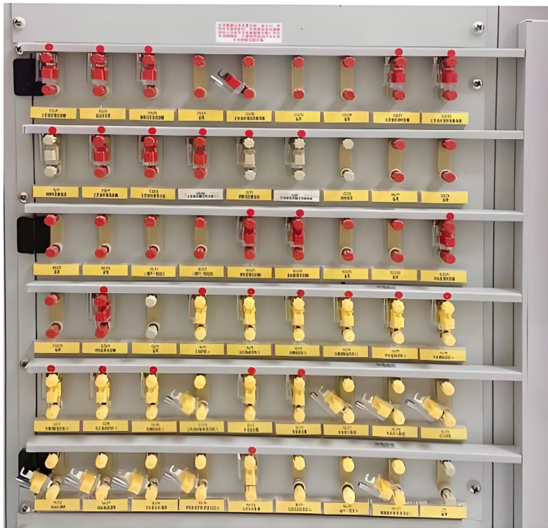
图 5-1 现场安装样板效果
